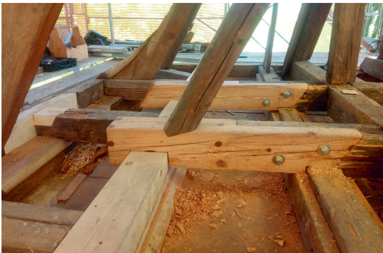
Sofern Balken nur partiell beschädigt waren, konnten Geschnittstücke vorgenommen und die intakten Bauteile durch neue Teilstücke ergänzt werden. Hier der Schwellenkranz des Hauptdachs.
