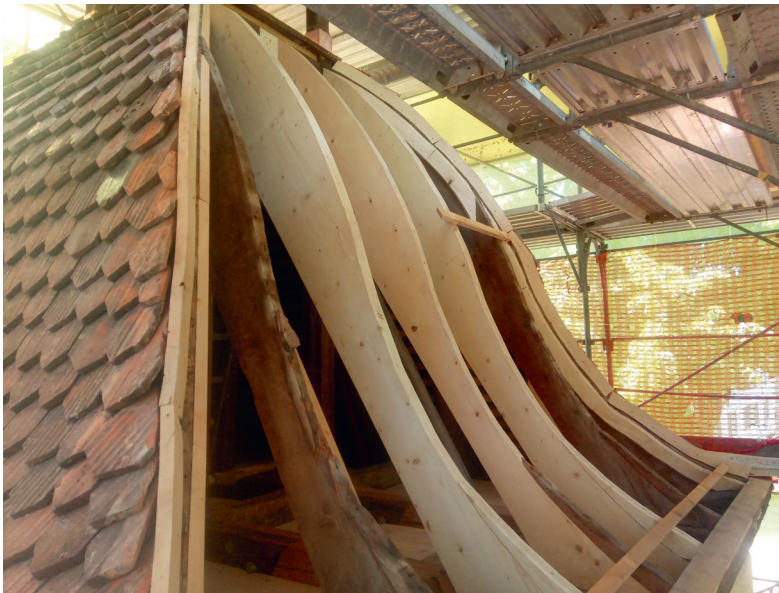
Beim Hauptdach wurden marode Sparren durch Dreischichtplatten (64 mm) ersetzt wie auch zusätzliche Sparren ergänzt. Bei den statischen Bemessungen vertraute das beteiligte Ingenieurbüro auf die fachliche Meinung und die Erfahrungswerte der Zimmerleute.
