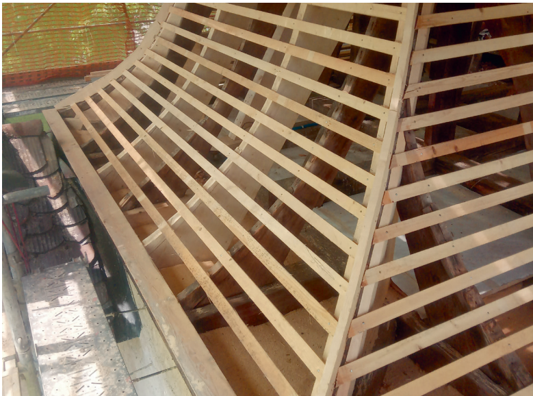
Die Sparren des Hauptdachs mussten ersetzt werden. Eine Dachdeckerei übernahm die Ziegeleindeckung.
