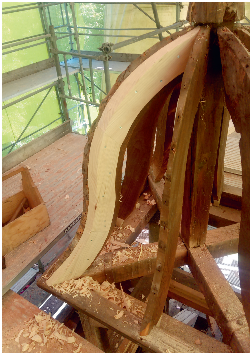
Im Dachreiter wurden die Gratsparren aufgedoppelt. Alle Holzarbeiten sind von Zimmermann Dominik Häussinger ausgeführt worden – er hat eine Zusatzausbildung zum Handwerker in der Denkmalpflege.
