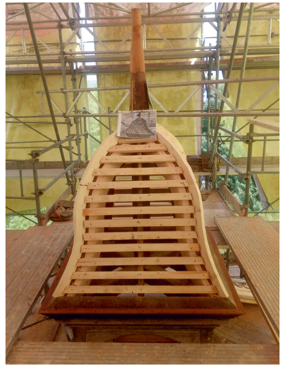
Auch der Dachreiter, die Spitze des Dachs, bedurfte einer Sanierung.
